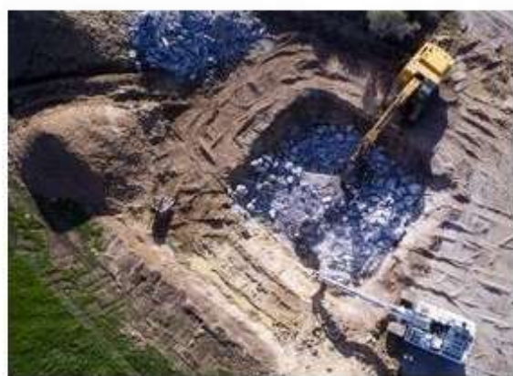
Le béton et les ferrailles sont intégralement recyclés. Quadran
